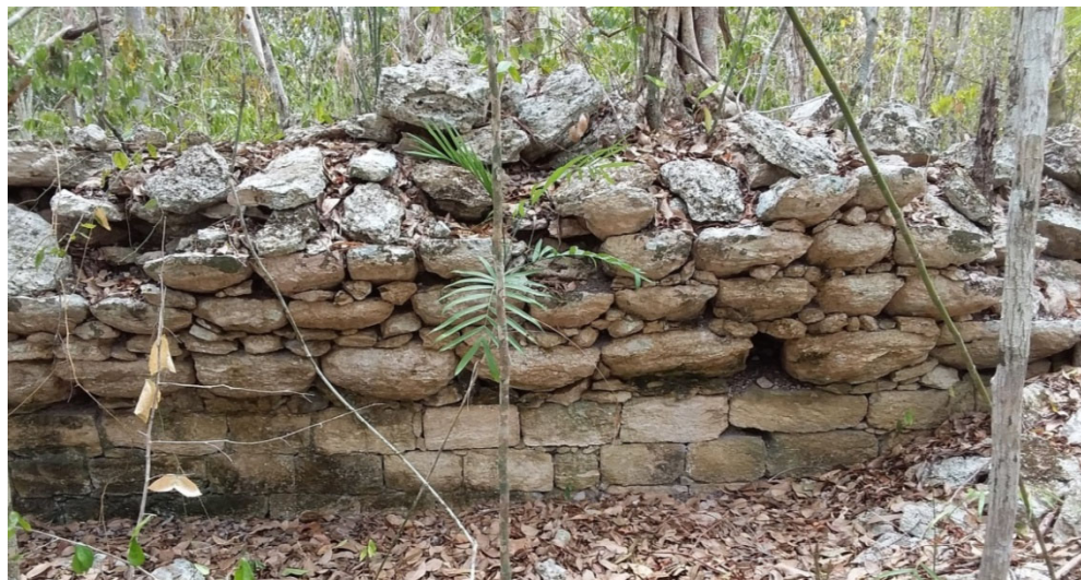
Figura 3.35. Grupo H24-e, restos del cuarto abovedado en uno de los edificios al noreste de la plaza principal.
