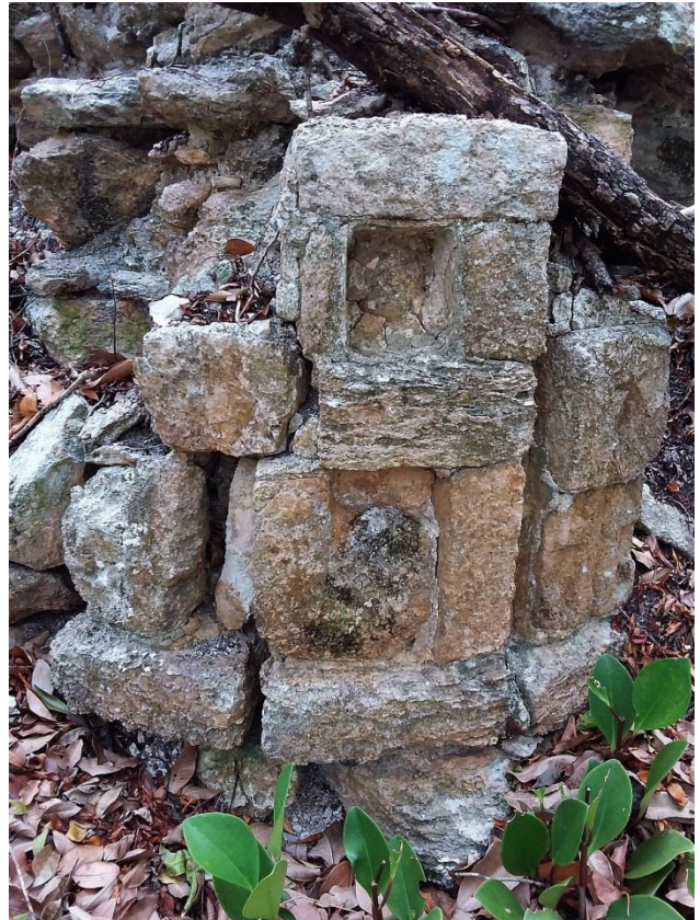
Figura 3.11. Grupo e19-b, elemento decorativo en el lado oriente de la estructura extrema norte.
