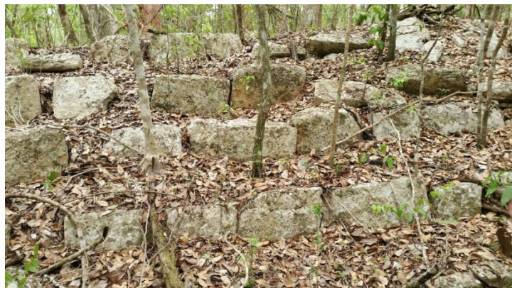
Figura 3.25. Grupo F15-b, escalinata en la estructura sur de la plaza principal.
