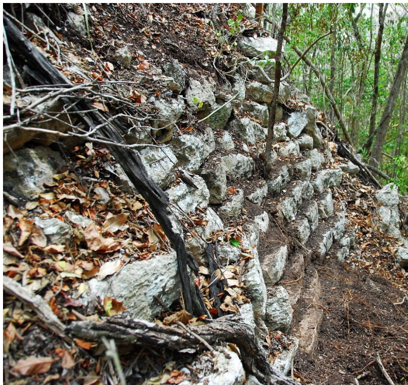
Figura 3.31. Grupo F24-b, talud escalonado sur de la pirámide este en el costado norte de la plaza.
