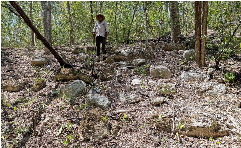
Figura 3.42. Ocomtún, complejo A-1, escalinata monumental en el talud sur de la acrópolis.
