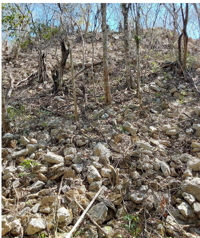
Figura 3.50. Ocomtún, Estructura B-1-b, talud sur.
