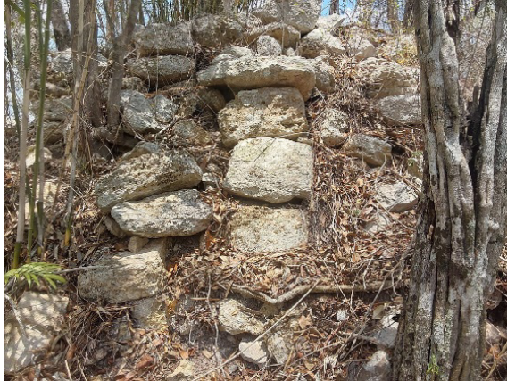
Figura 3.41. Ocomtún, mampostería en la parte alta de la Estructura A-1-a, vista hacia el oriente.
